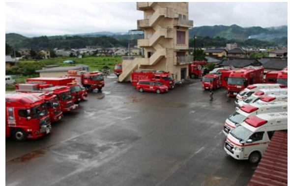
消防本部 庁舎前
