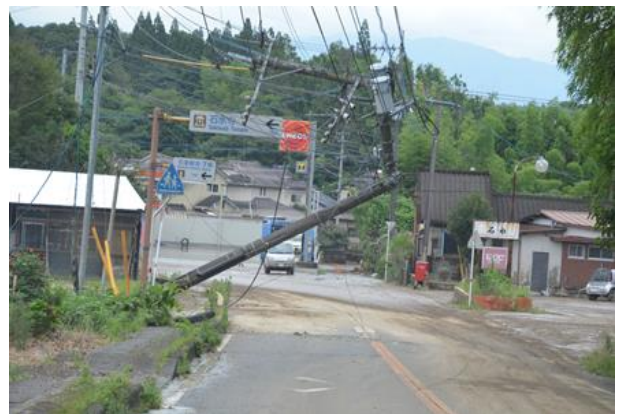
(道路上に倒れた電柱)
