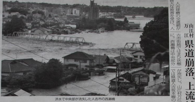
洪水で中央部が流失した人吉市の西瀬橋
