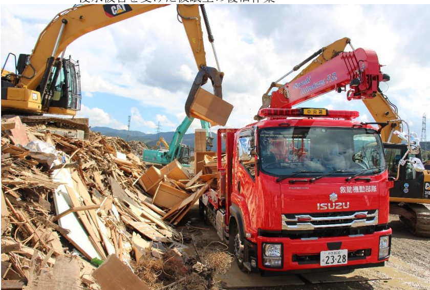
災害ゴミ仮置場へ重機搬送車にて搬送
