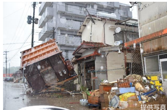
住家被害(人吉市下青井町)
