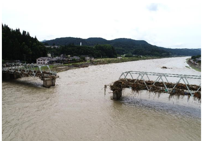
西瀬橋の被害状況
