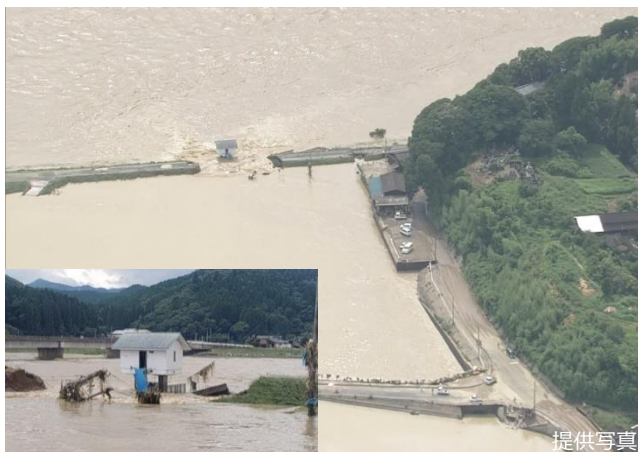
右岸 56.4k 付近 堤防決壊状況(八代河川国道事務所より提供)
