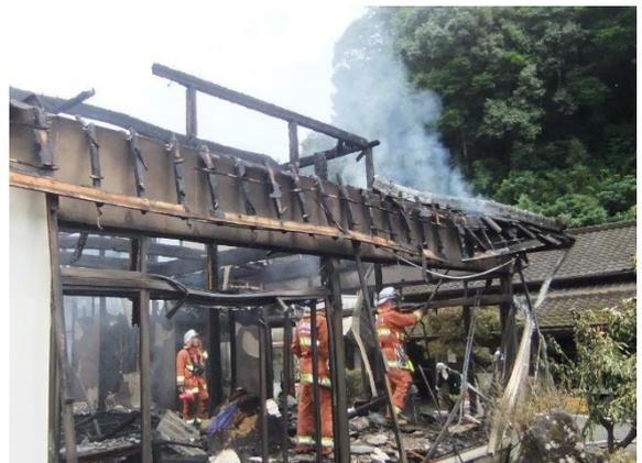
焼損建物 木造瓦葺モルタル壁一部2階建て
