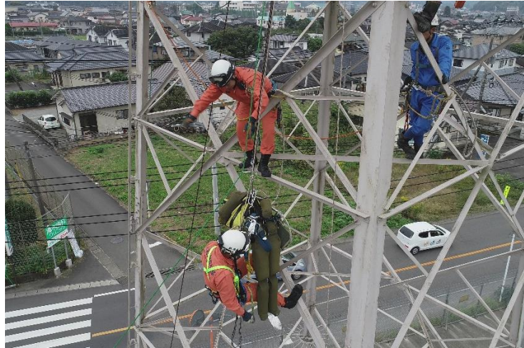
鉄塔上作業員救出合同訓練
